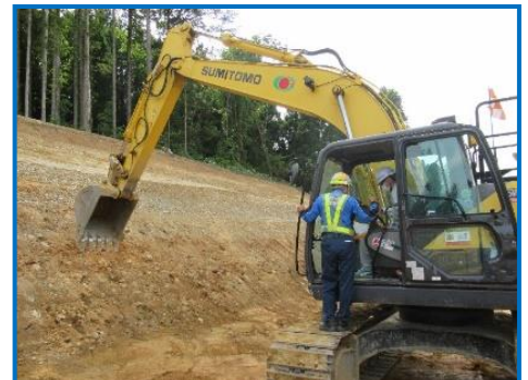
【実習】 ICT建設機械の操作
