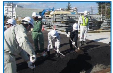
【実習】 アスファルト舗装
