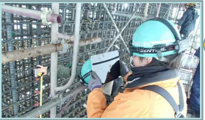
▼受注者側(施工現場)
