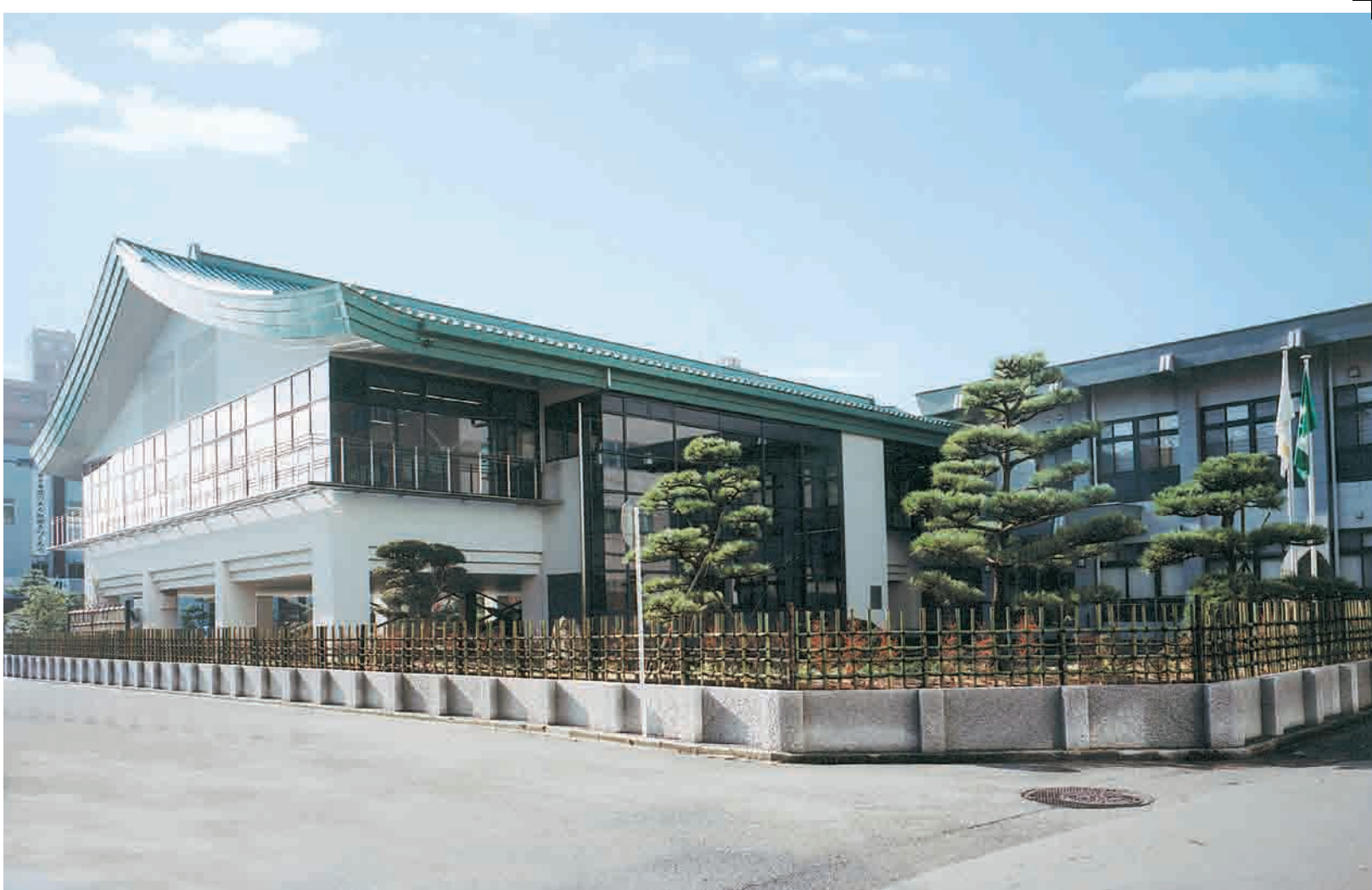
(社)秋田県建設業協会・会館
