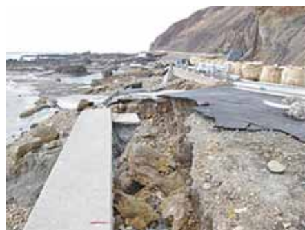
「爆弾低気圧」の高波により決壊した県道(男鹿市潮瀬崎)
