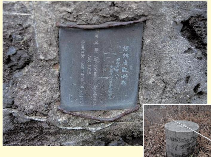
各地で見られる三角点（一等～四等）は三角測量に用いられる経度、緯度、高度の基準になるポイントのことである。永久標識に分類される測量標は明治新政府によって設置規格が定められたが、その後、内務省地理局の三角測量を経て国内の測量業務は明治一七年（二八八四）に参謀本部に移管されて以後、その設置と管理は、戦前は参謀本部陸地測量部、戦後は国土地理院によって行われている。
