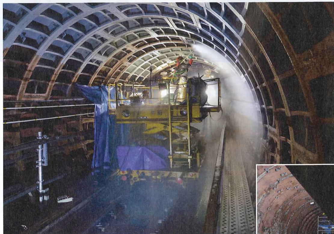
写真3 ■ ウォータージェットによるケレンでダクタイルセグメントのさびを落とす。昇降台車の上で2人が作業。2時間弱で30m²の範囲を施工する。さび落としが終わった箇所は後日、組み立て式の足場を使って防錆塗装を施す
