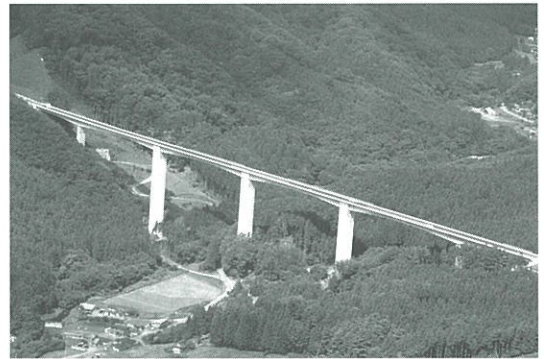
写真-4 PC橋の耐久性向上対策を試行した「越喜来高架橋」
