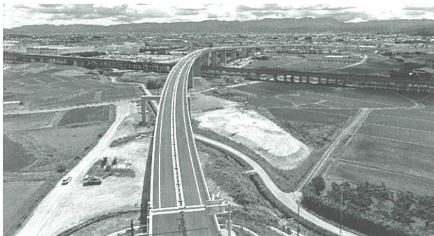
写真-6 RC床版の耐久性向上対策を試行した「桑折高架橋」
