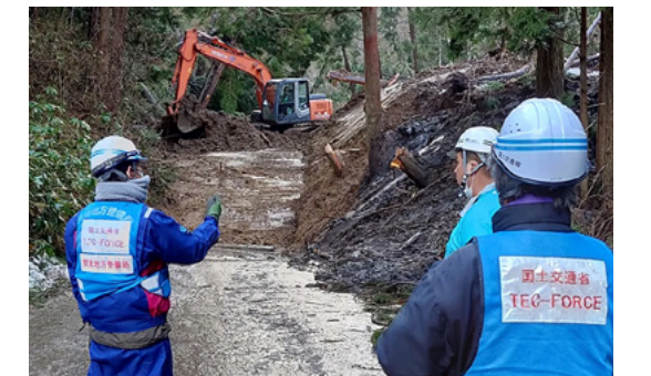
通行不能となった県市町管理道路の緊急復旧を行い、孤立解消や支援物資等の輸送路を確保
